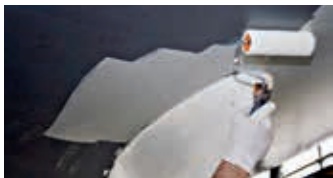
Påfør bundmaling oven på grunderen
