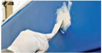
Udfyld ujævnheder med spartel
