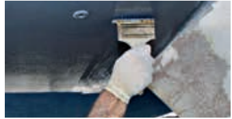
Overstryg Hempel's High Protect II i modsat retning med pensel
